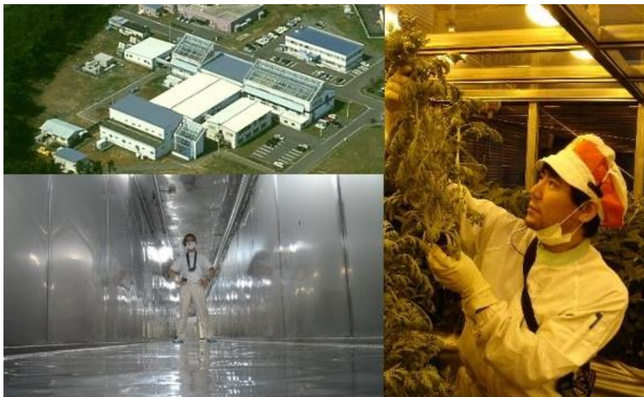
図 2：ミニ地球 CEEF の外観（左上）。この建屋の内部に閉鎖施設を構築している。コンクリートを使用していないため、このようにステンレス張りの独特な内観（左下）。植物栽培区で長く太く育ったシュンギクを収穫する筆者（右）。
